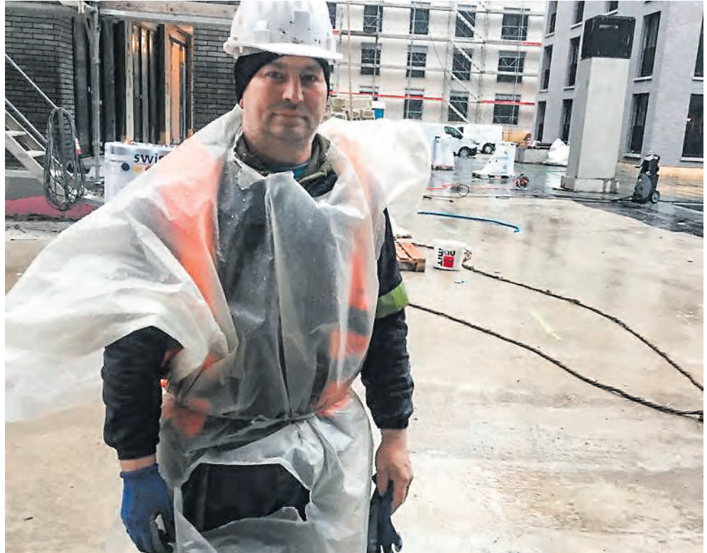
Die rumänischen Bauarbeiter mussten mit völlig ungenügender Ausrüstung und praktisch ohne Sicherheitsvorkehrungen arbeiten. Bild: Cristian Istrati
